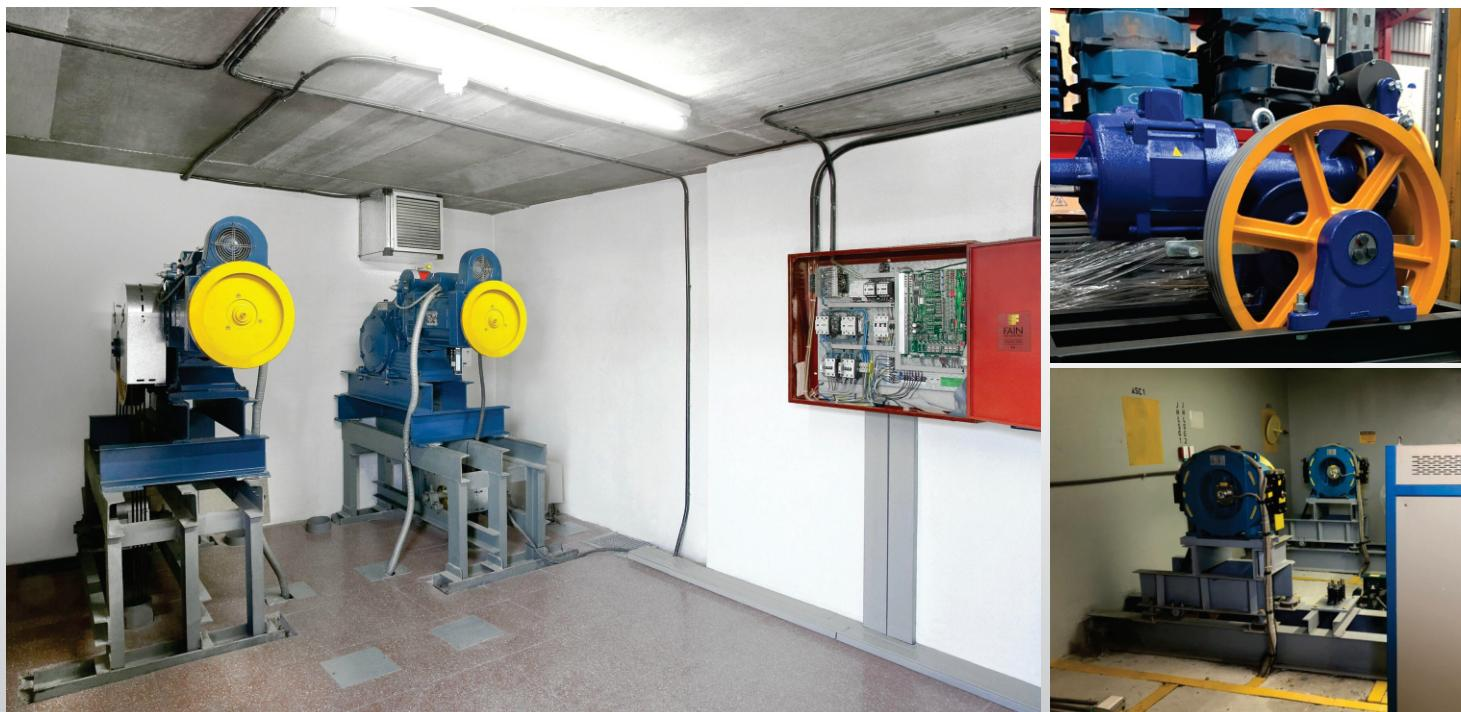
Una sala de máquinas es un espacio dedicado que alberga los componentes críticos de un sistema de ascensor, como el motor, la bomba, el controlador y otros mecanismos esenciales.
